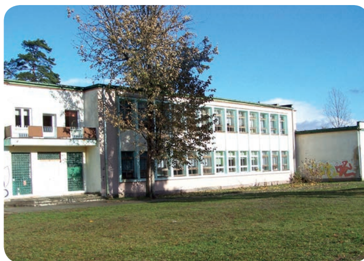
Budynek Szkoły Podstawowej w Wysokiej. Fot. M. Kowalski
