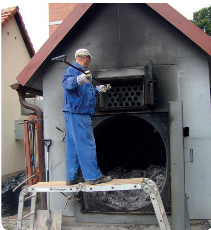
Czyszczenie kotła – Myślibórz 11. Fot. T. Horoszko
