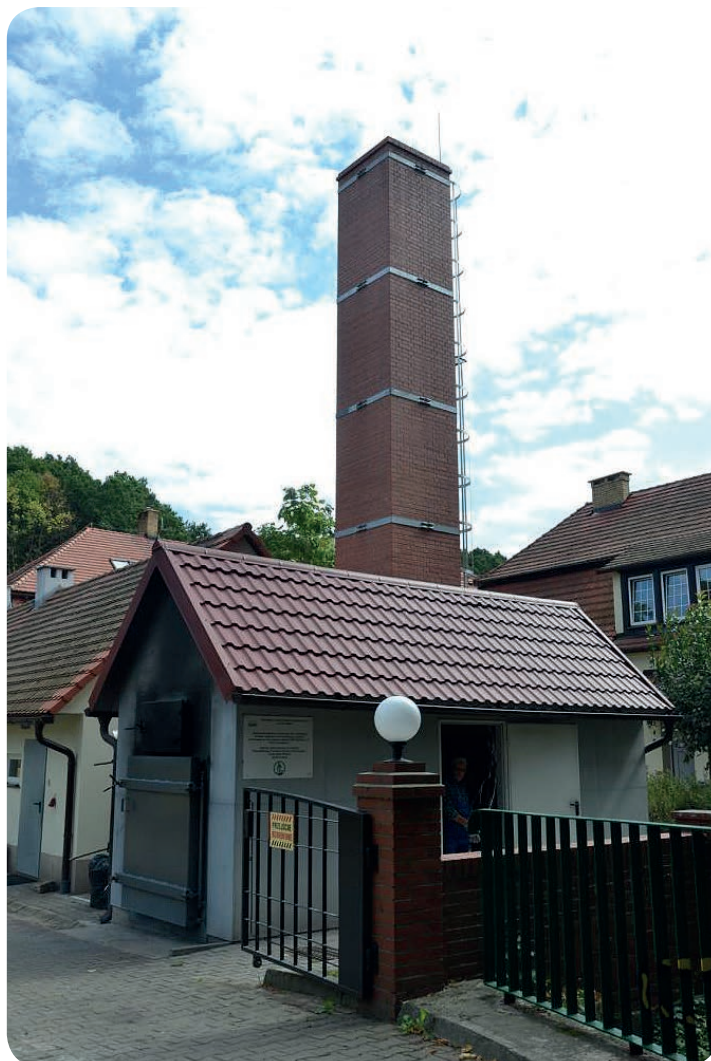
Kotłownia na biomasę o mocy 180 kW DZPK O/Legnica – Myślibórz 11. Fot. T. Horoszko
