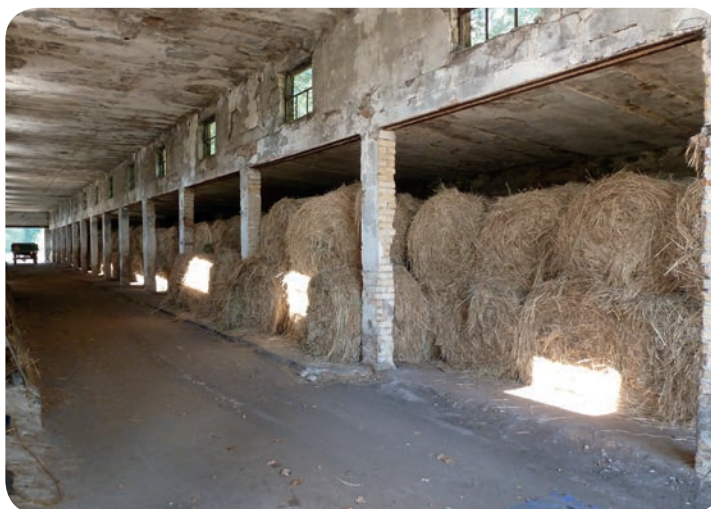
Magazyn główny biomasy – Ostaszów. Fot. M. Cieślak
