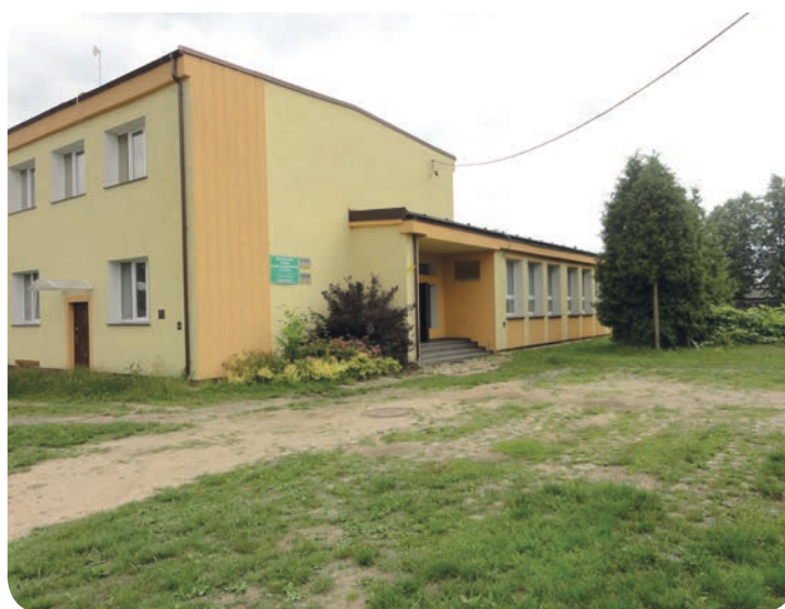
Budynek siedziby DZPK O/Legnica – Piotrowice 89. Fot. M. Kowalski
