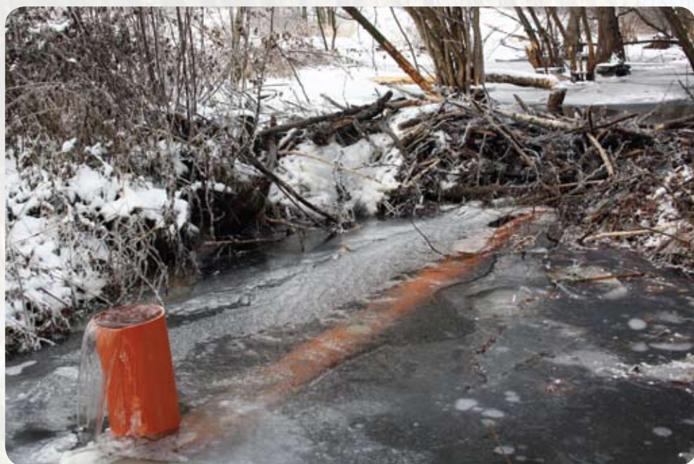
Fot. Urządzenie regulujące poziom wody w cieku wodnym (KW)
